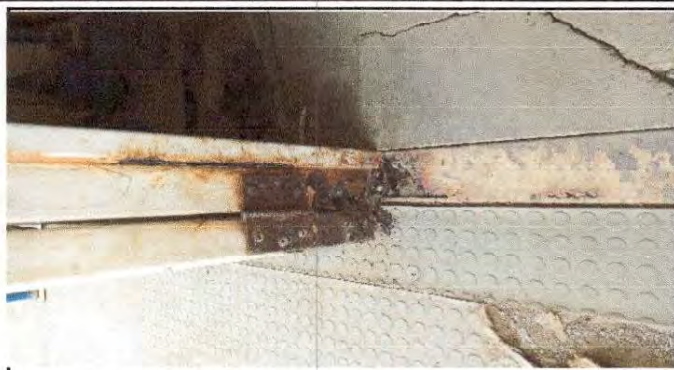
Foto 2: Sustitución de puerta
