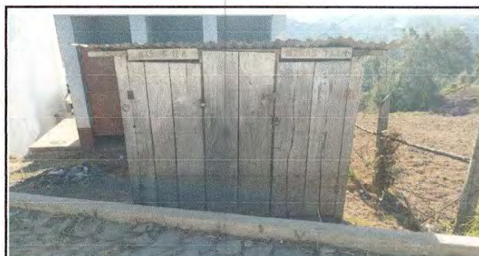
Foto 4: Sustitución de puerta en servicios sanitarios
