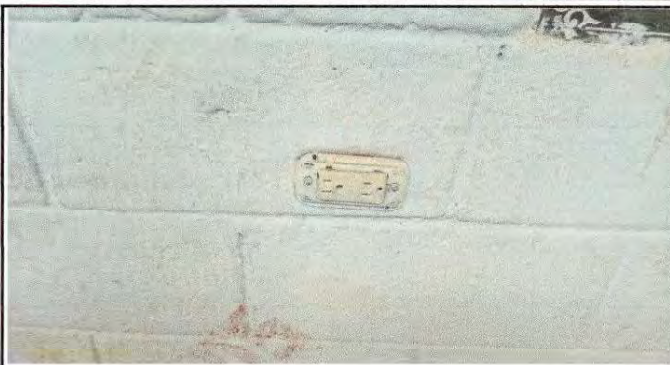
Foto 13: Sustrucción de tomacorrientes
