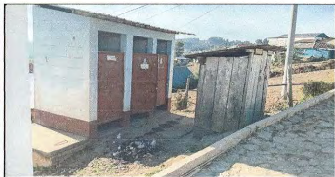
Foto 3: Sustitucion de puerta en servicio sanitarios
