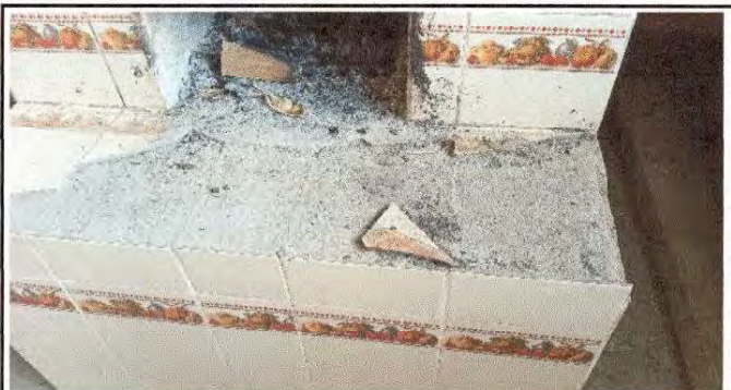
Foto 15: Instalación de azulejo en estufa rural
