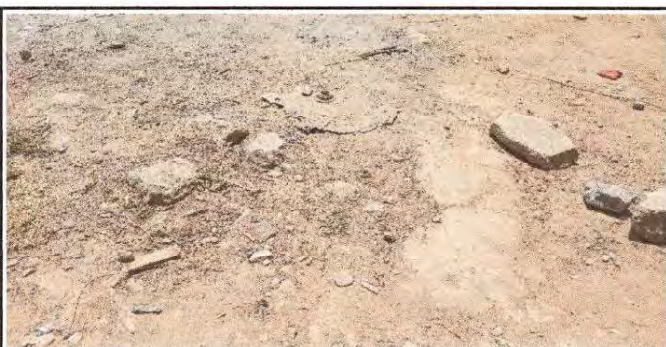
Foto 11: Reparación de planchas de concreto de patio
