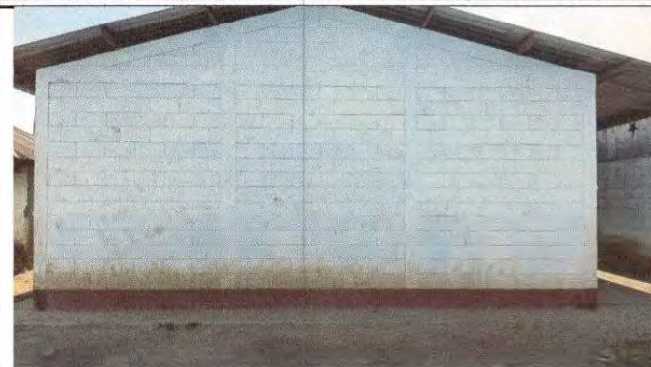
Foto 8: Pintura en muros exteriores e interiores
