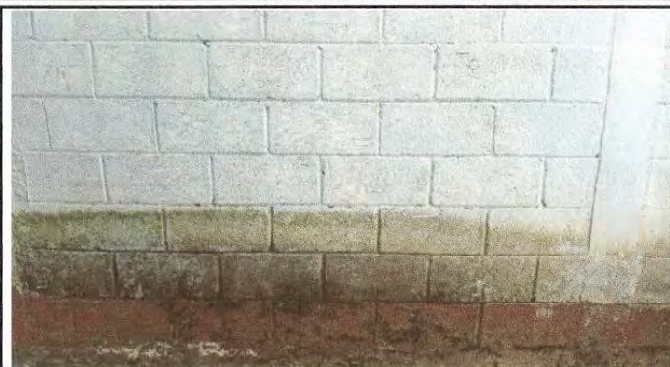
Foto 7: Pintura en muros exteriores e interiores
