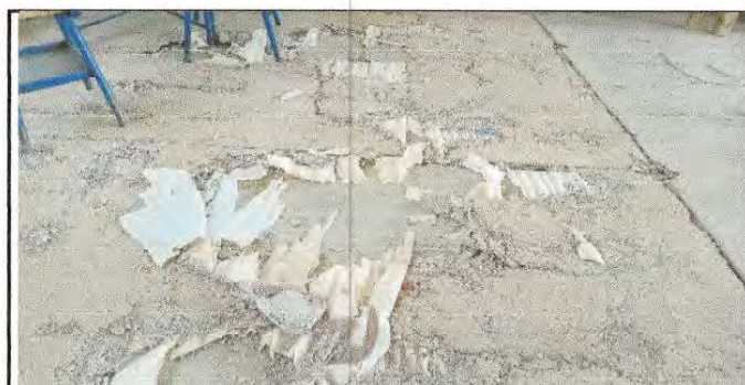
Foto 6: Sustitución de piso de torta de concreto
