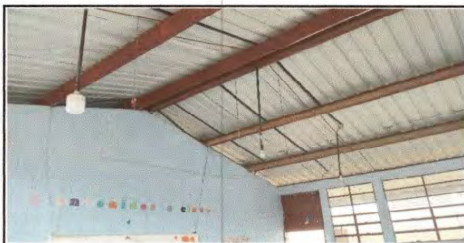
Foto 12: Sustitución de lámparas tipo LED
