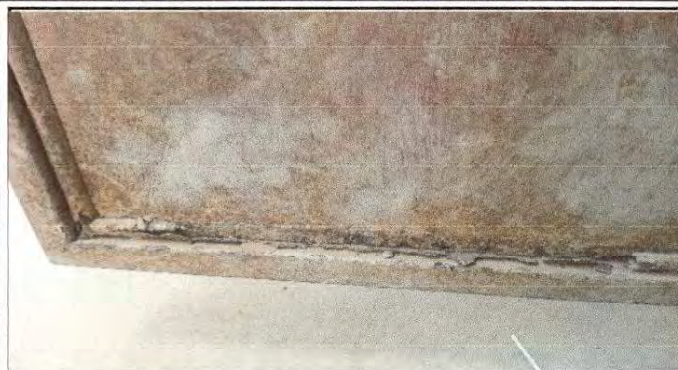
Foto1: Sustitución de puerta
