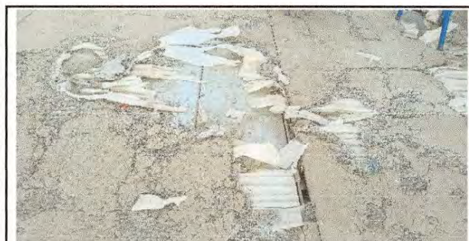
Foto 5: Sustitución de piso de torta de concreto
